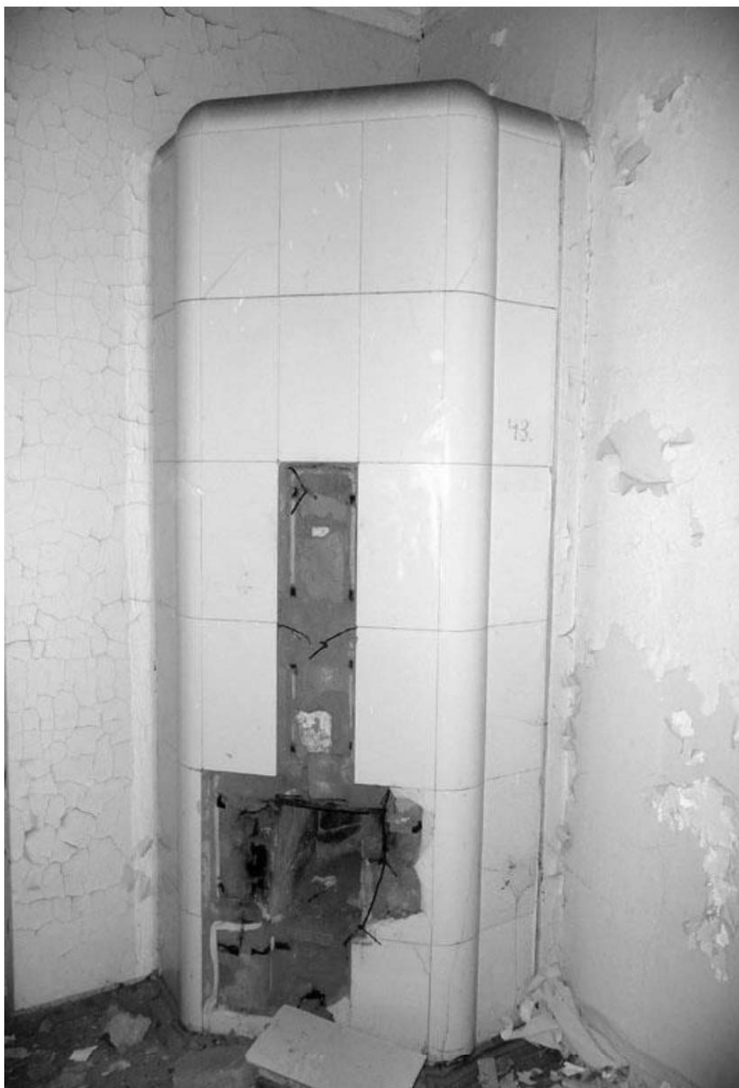
Рис. 44. Комарово. Морская ул. 8. Дача литера Б. Комната 7. Печь. 2008. Фото. Из материалов историко-культурной экспертизы ОКН «Дача», выполненной ООО «ДевРос» в 2012 г. Эксперты: Богданова Е.И., Полетайкин В.В., Иониди Э.Л.
