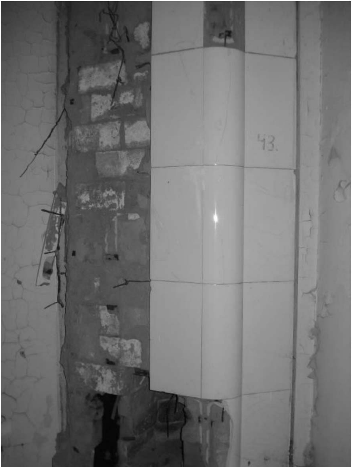
Рис. 80. Дача литера Б. Комната 7. Печь с частично утраченной облицовкой из белого кафеля. Декабрь 2011 г.
