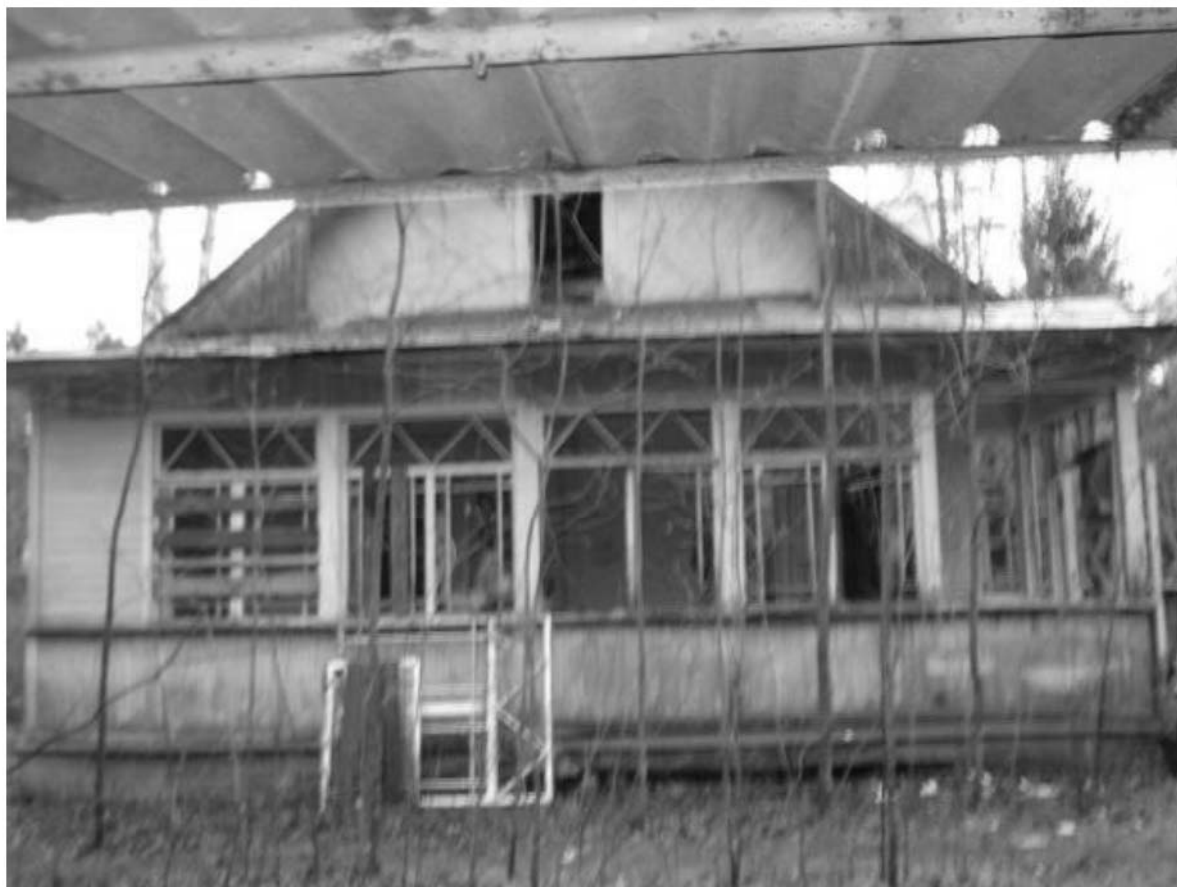
Рис. 62. Дача литеры Б. Южный фасад. Декабрь 2011 г.
