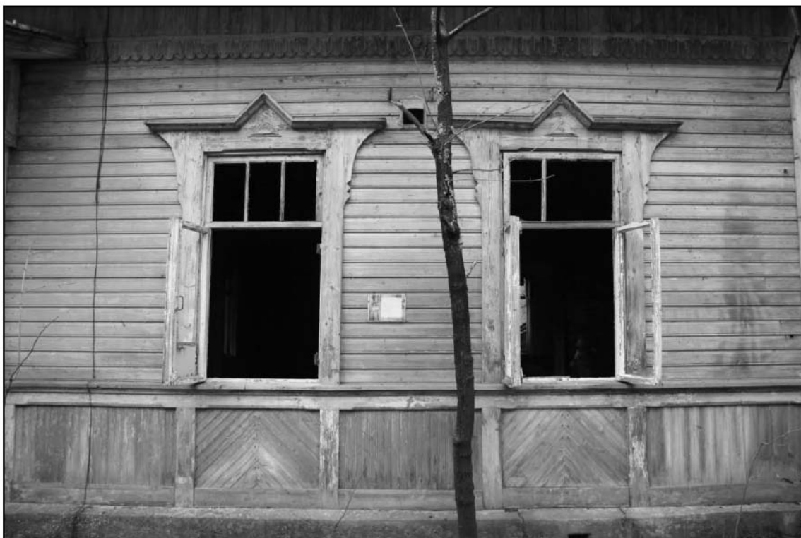
17. Объект культурного наследия «Дача» (пос. Комарово. Морская ул., 8). Окна с наличником восточного фасада.
