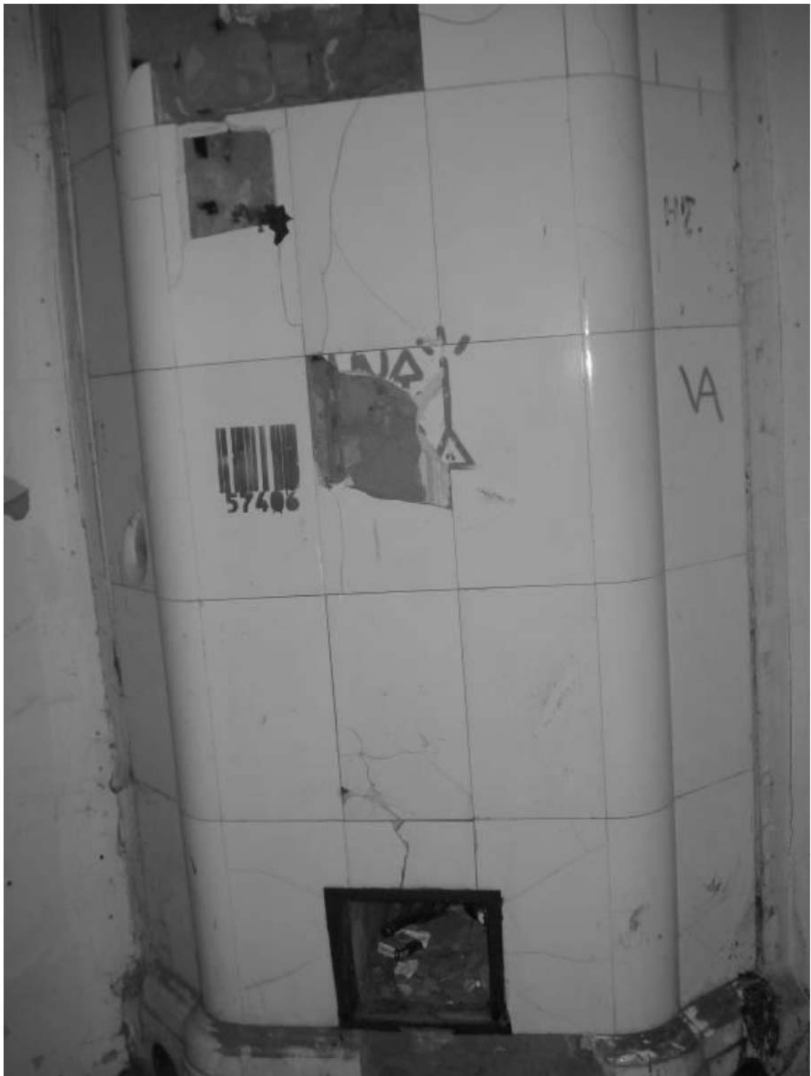
Рис. 79. Дача литера Б. Комната 4. Печь с облицовкой из белого кафеля. Декабрь 2011 г.
