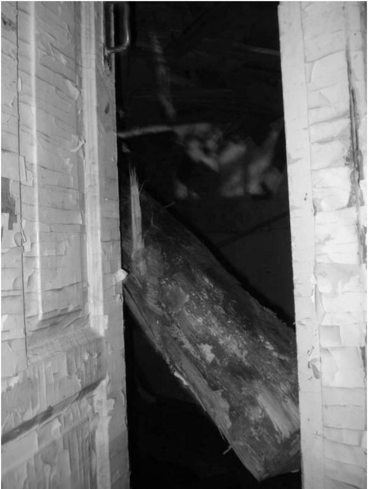
Рис. 85. Дача литера Б. Помещения 1-го этажа северо-запада. Декабрь 2011 г.
