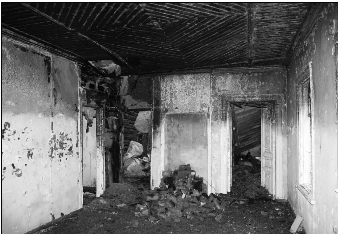
25. Объект культурного наследия «Дача» (пос. Комарово. Морская ул., 8). Помещение № 10. Вид на северную стену от веранды.
