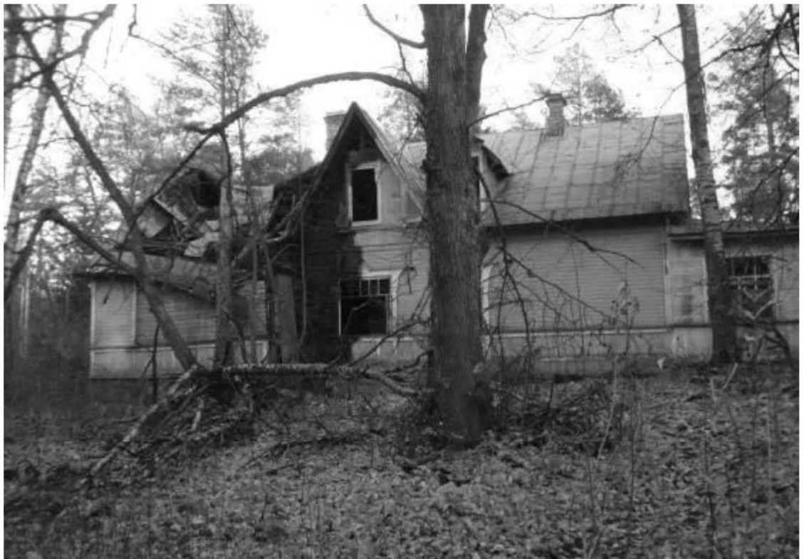
Рис. 54. Дача литера Б. Западный фасад. Декабрь 2011 г.
