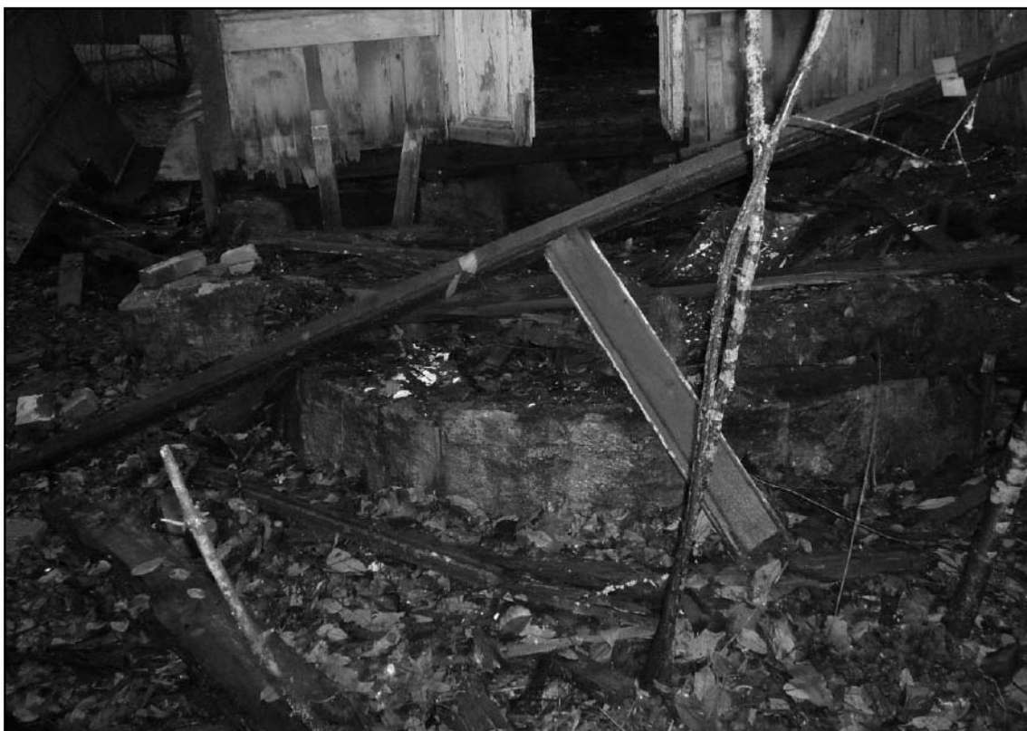
12. Объект культурного наследия «Дача» (пос. Комарово. Морская ул., 8). Фрагмент восточного фасада. Фундаментные блоки террасы.
