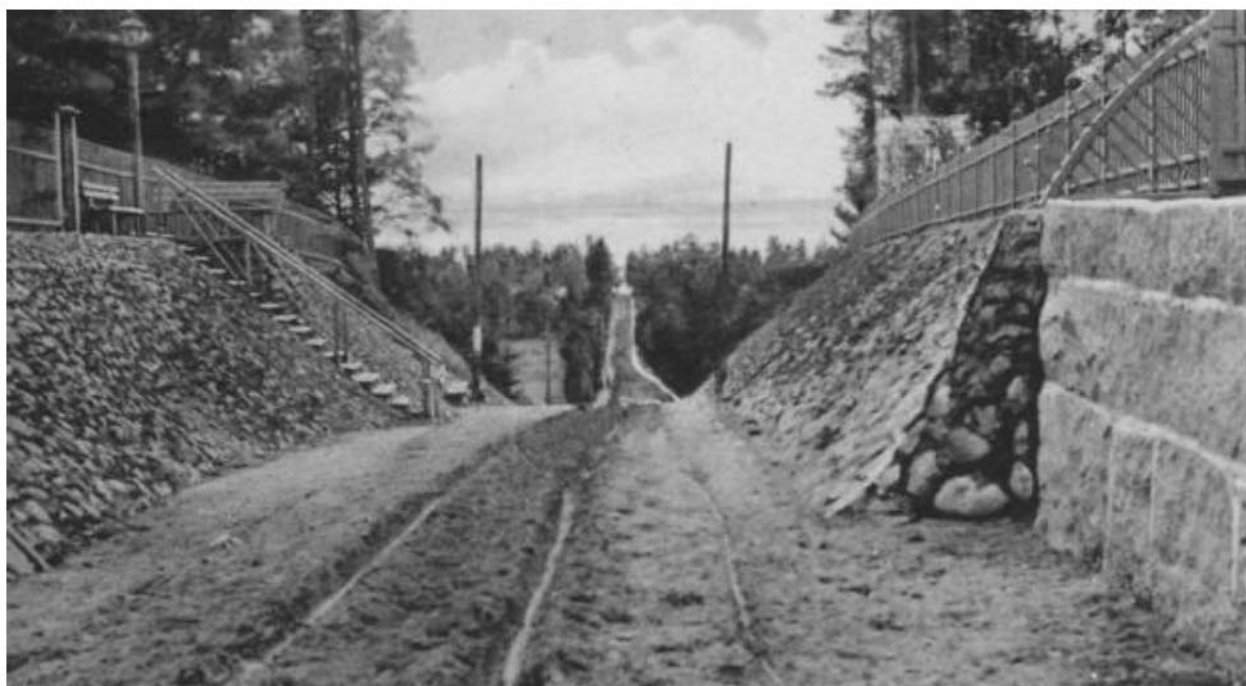
Рис. 19. Комарово (Келломяки). Морская улица в сторону залива. Видна подпорная стенка из гранитных блоков и булыжного камня. Справа за оградой участок дачи И.И Чижова. 1910(?) г. Частное собрание.
