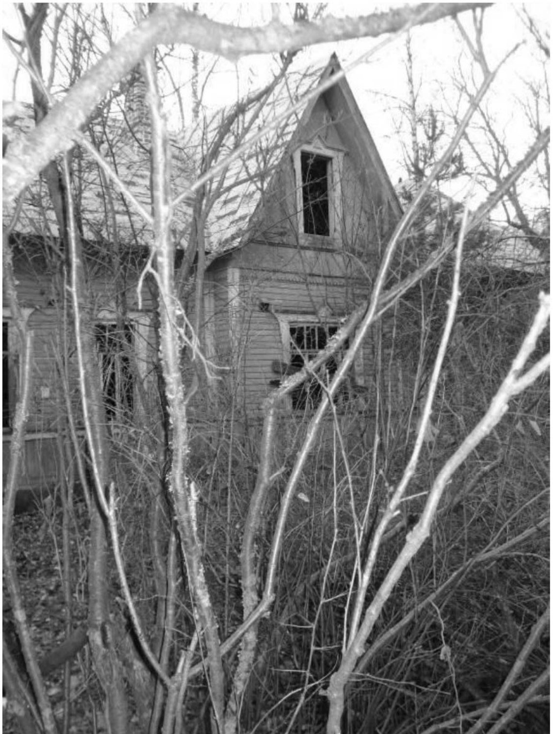
Рис. 63. Дача литера Б. Восточный фасад. Декабрь 2011 г.
