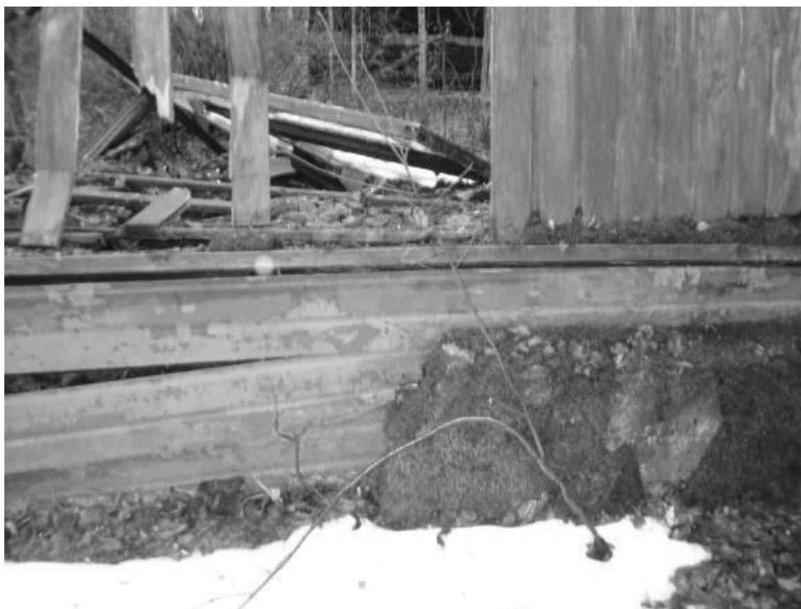
Рис. 93. Дача литера Б. Веранда. Фундамент. Декабрь 2011 г.
