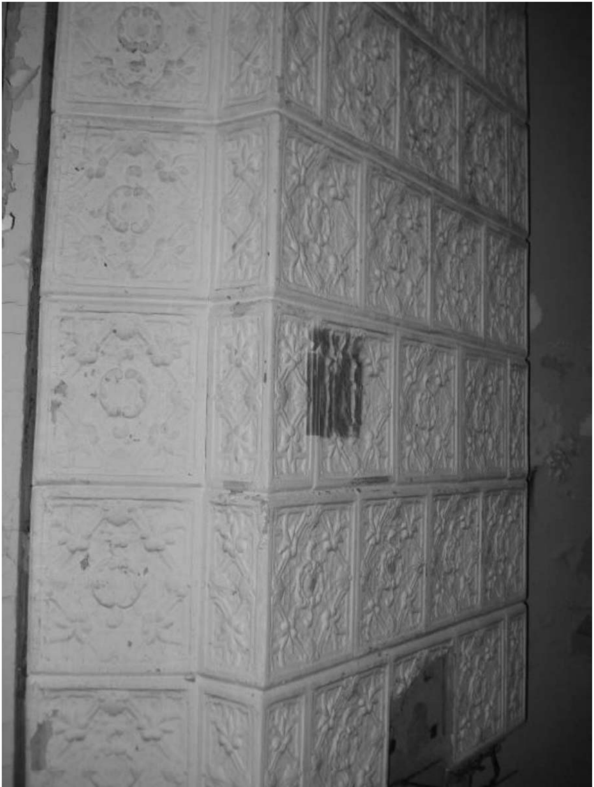
Рис. 76. Дача литеры Б. Комната 2. Печь с облицовкой кафелем с орнаментальным декором. Декабрь 2011 г.
