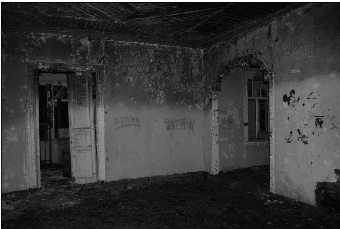
26. Объект культурного наследия «Дача» (пос. Комарово. Морская ул., 8). Помещение № 10. Дверной проем на веранду в помещении № 1 и арочный проем в помещении № 2.
