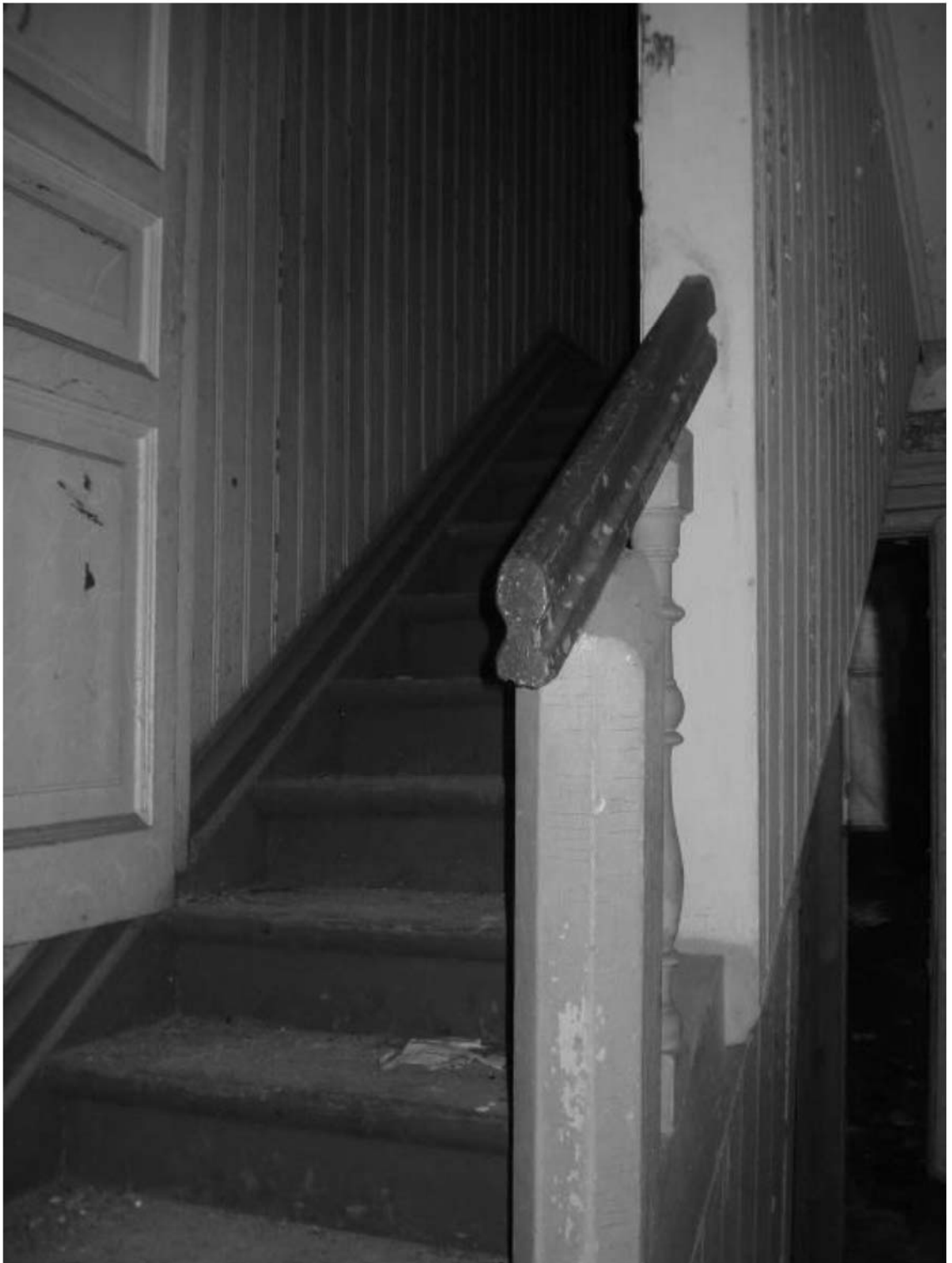
Рис. 86. Дача литера Б. Комната 9. Внутренняя лестница на 2-й этаж. Декабрь 2011 г.
