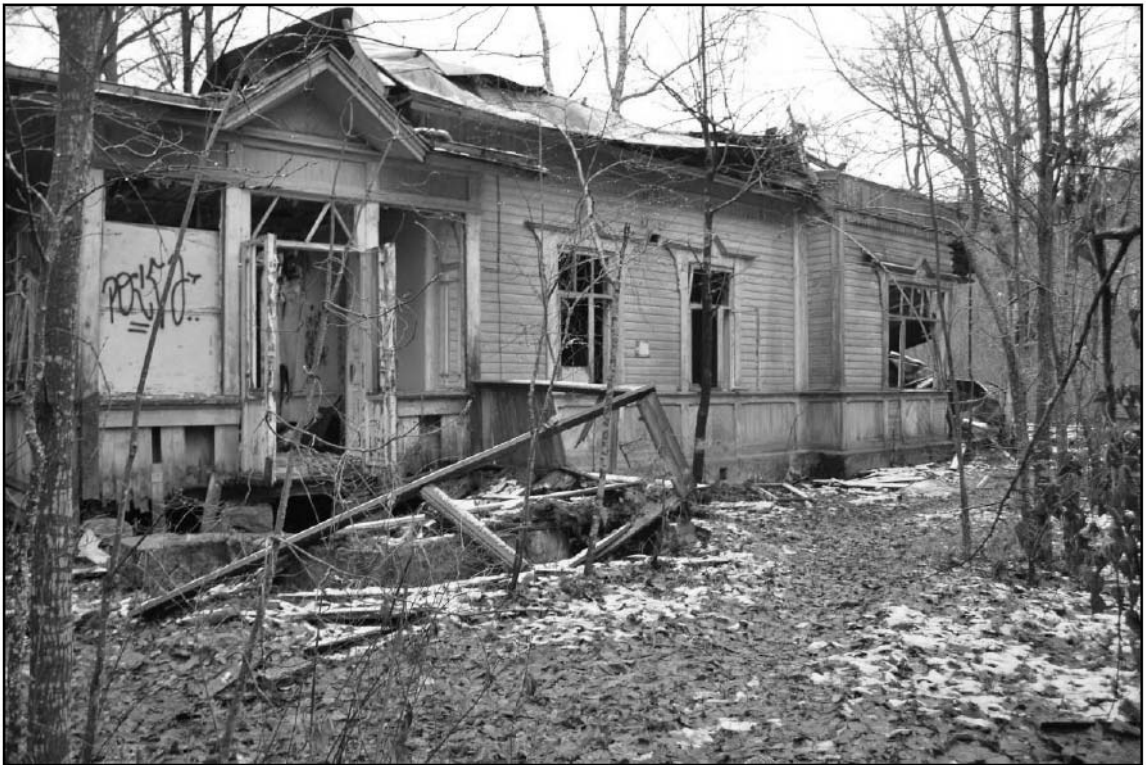
1. Объект культурного наследия «Дача» (пос. Комарово. Морская ул., 8). Общий вид восточного фасада. Вид на север.
