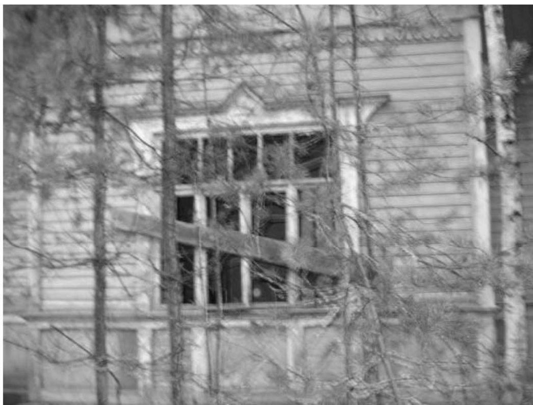
Рис. 91. Дача литера Б. Восточный фасад. Окно и наличник ризалита. Декабрь 2011 г.
