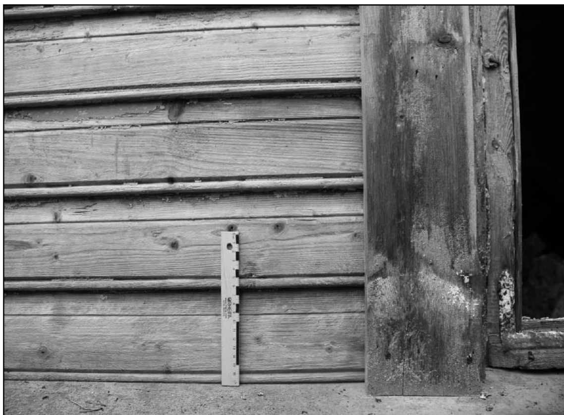
20. Объект культурного наследия «Дача» (пос. Комарово. Морская ул., 8). Фрагмент отделки стен восточного фасада.
