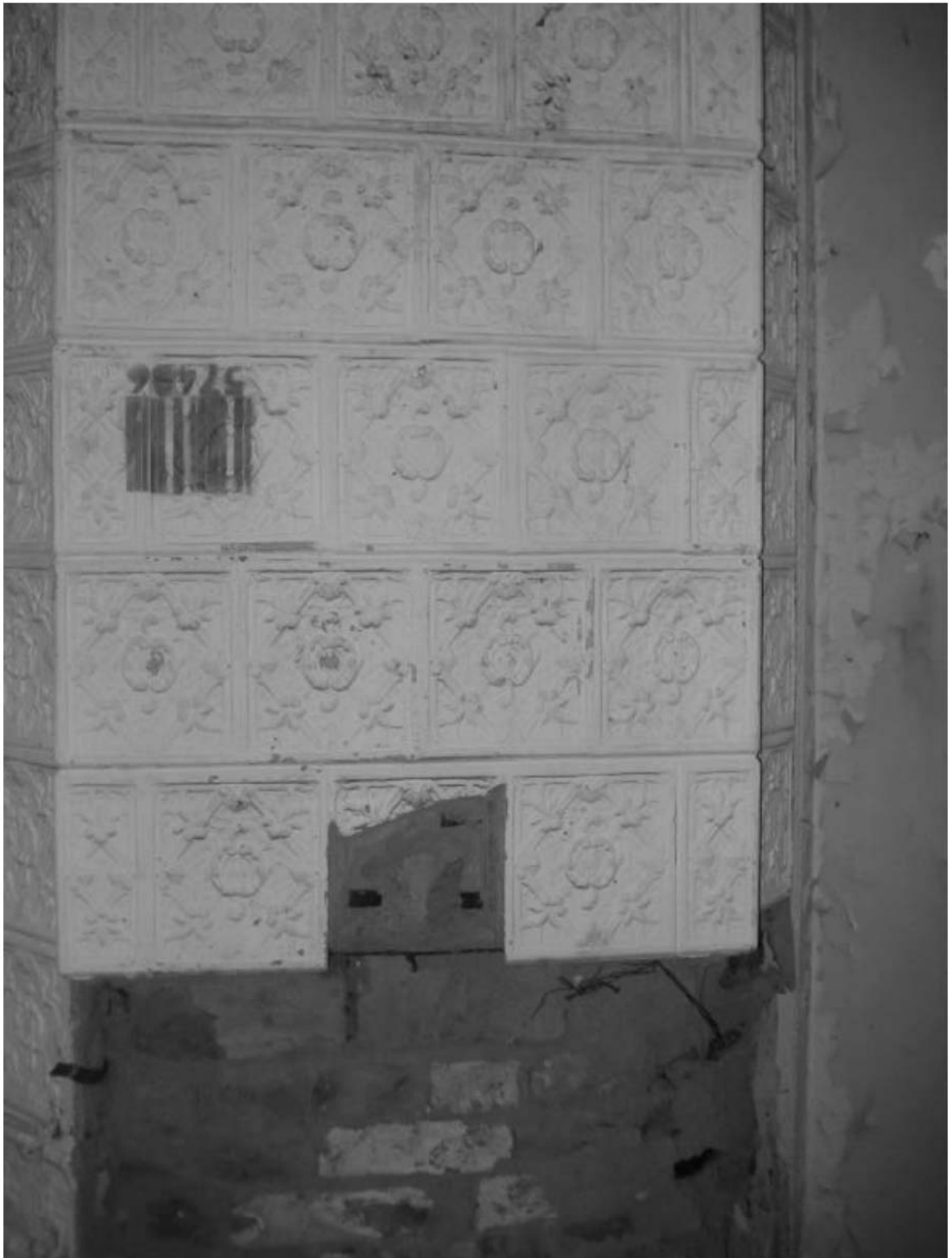
Рис. 75. Дача литеры Б. Комната 2. Печь с облицовкой кафелем с орнаментальным декором. Декабрь 2011 г.
