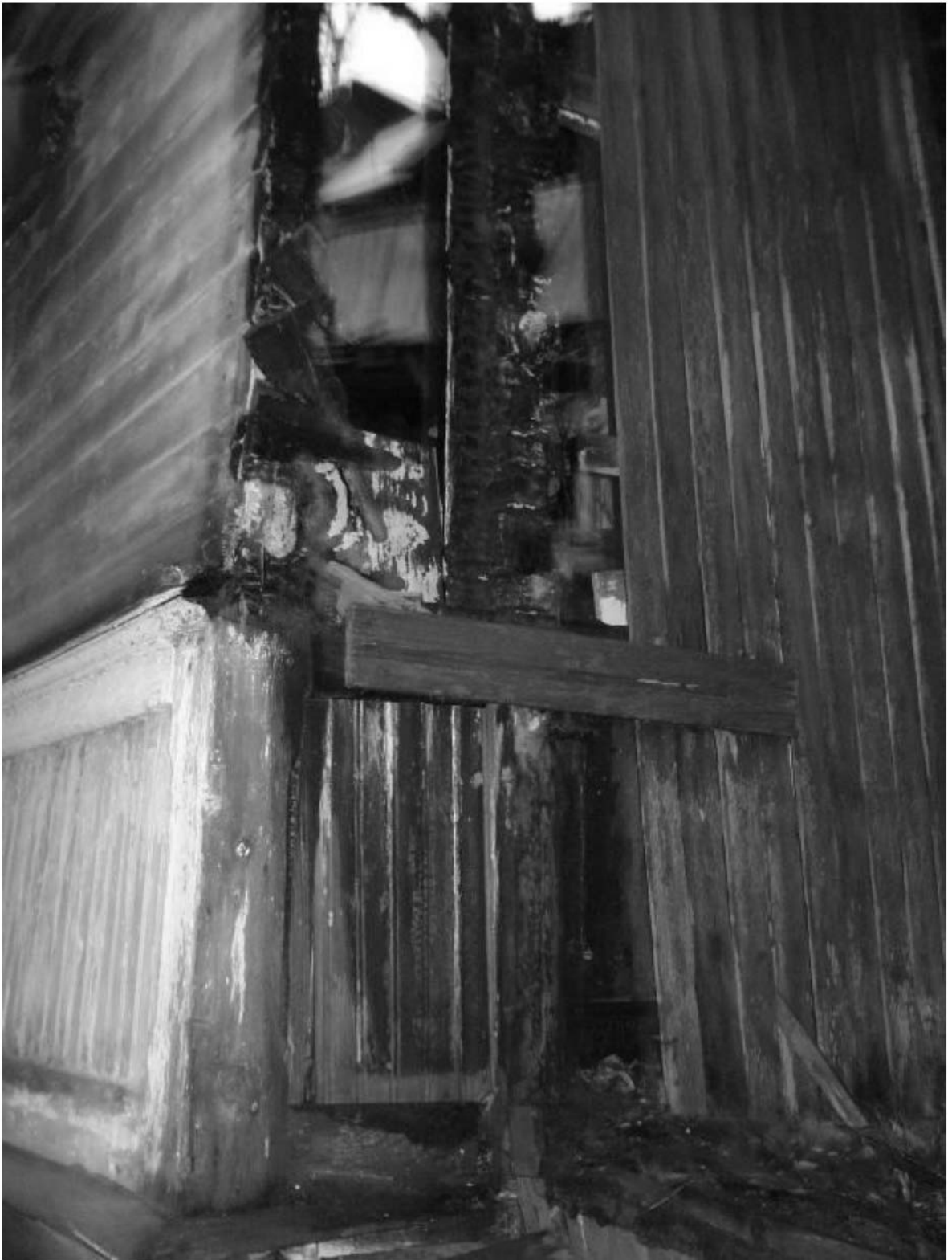
Рис. 60. Дача литера Б. Западный фасад. Декабрь 2011 г.
