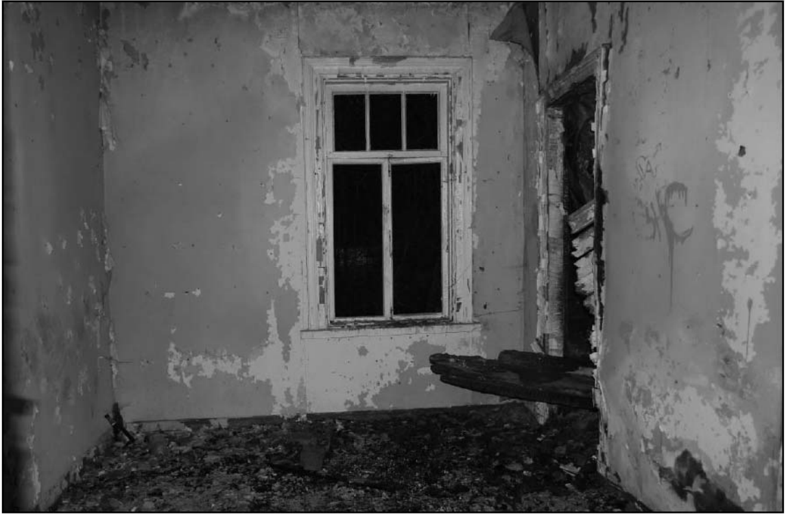
35. Объект культурного наследия «Дача» (пос. Комарово. Морская ул., 8). Помещение № 3. Оконный проем в восточной стене.
