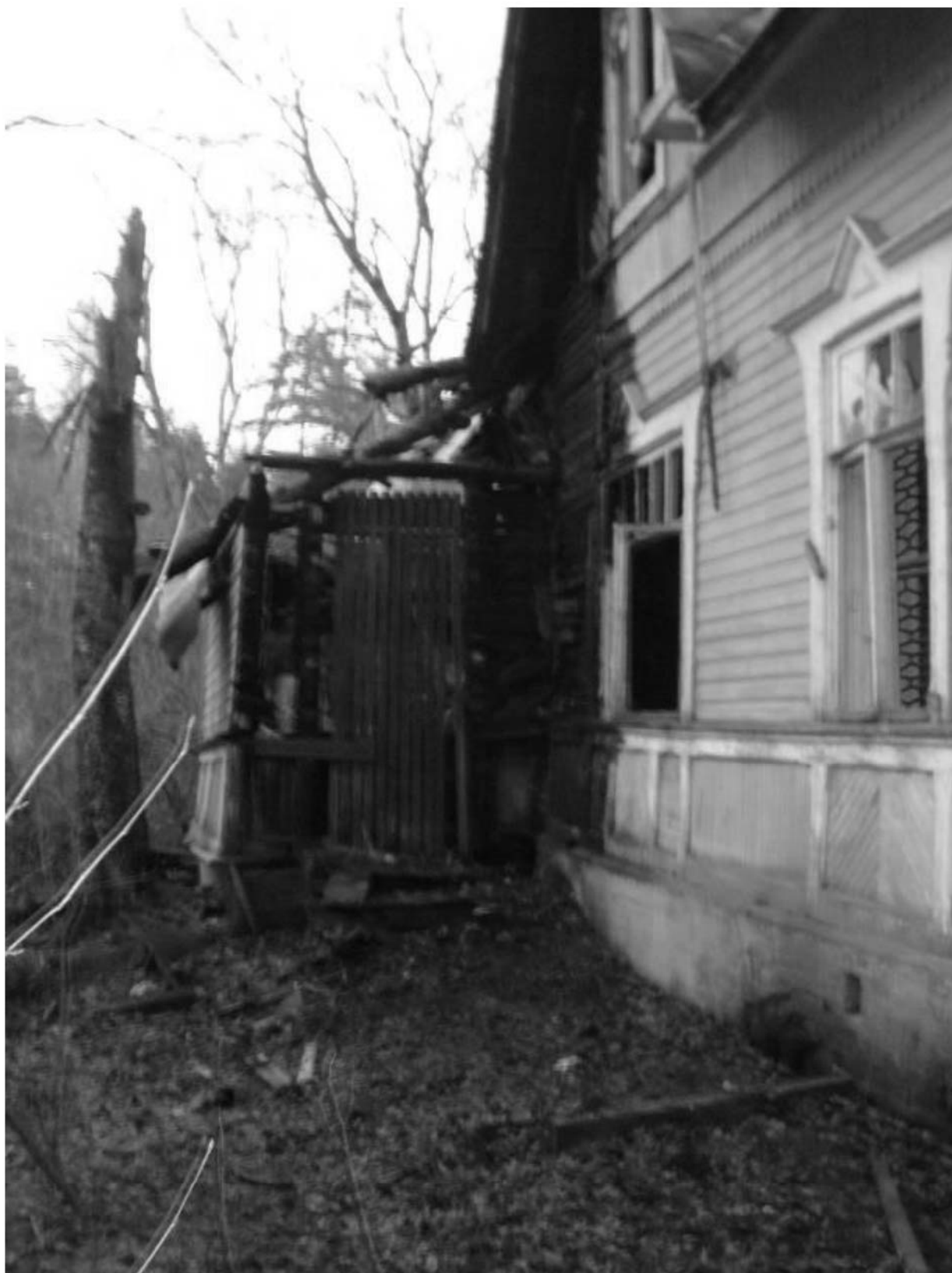
Рис. 56. Дача литера Б. Западный фасад. Декабрь 2011 г.
