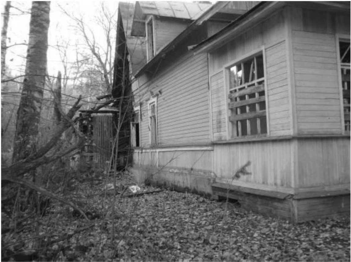
Рис. 55. Дача литера Б. Западный фасад. Декабрь 2011 г.
