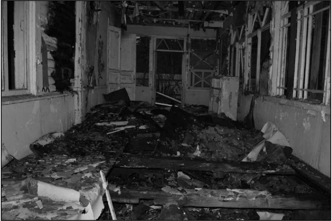
23. Объект культурного наследия «Дача» (пос. Комарово. Морская ул., 8). Помещение № 1. Веранда. Вид в сторону входа.
