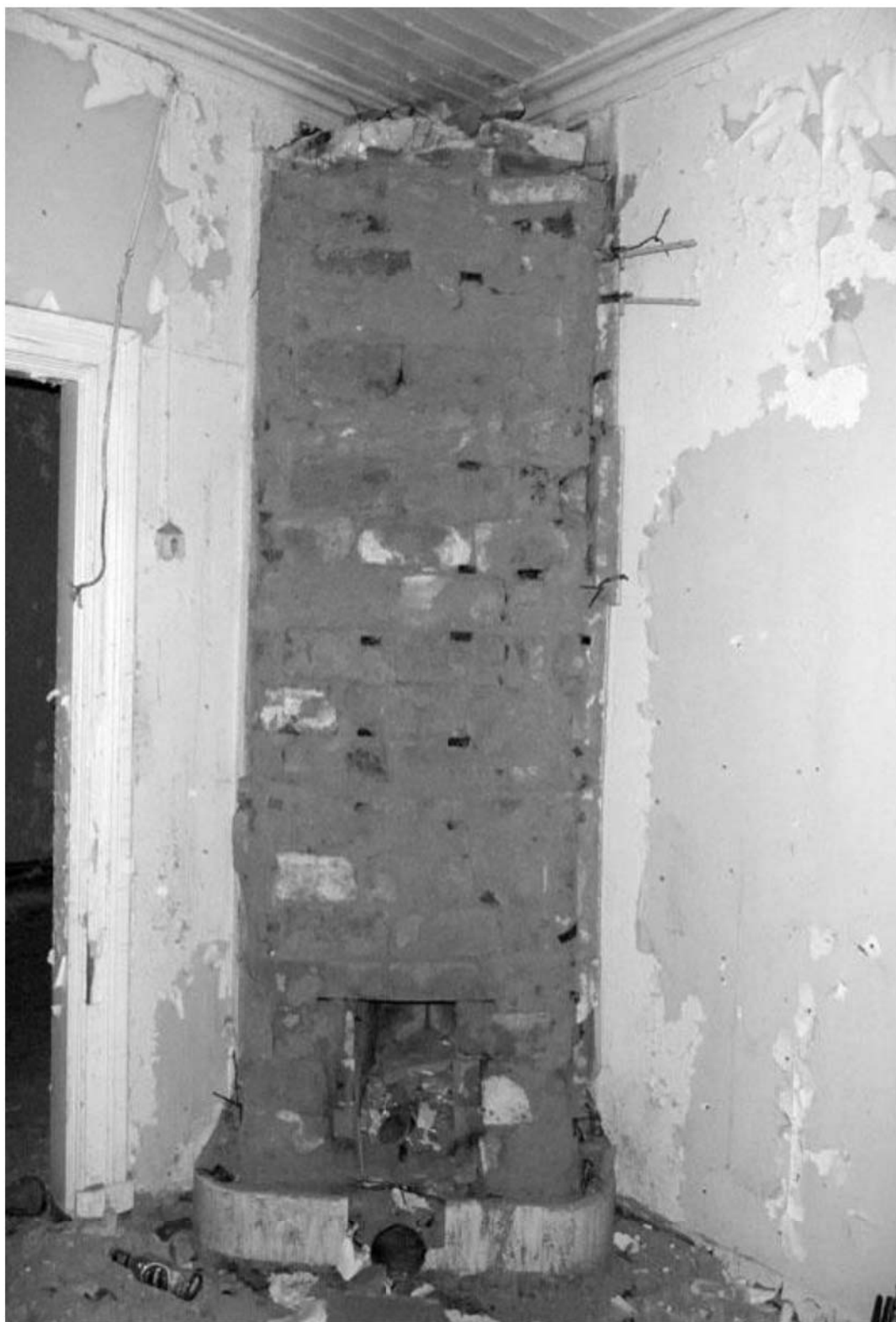
Рис. 46. Комарово. Морская ул. 8. Дача литера Б. Комната 3. Печь, облицовка утрачена. 2008. Фото. Из материалов историко-культурной экспертизы ОКН «Дача», выполненной ООО «ДевРос» в 2012 г. Эксперты: Богданова Е.И., Полетайкин В.В., Иониди Э.Л.
