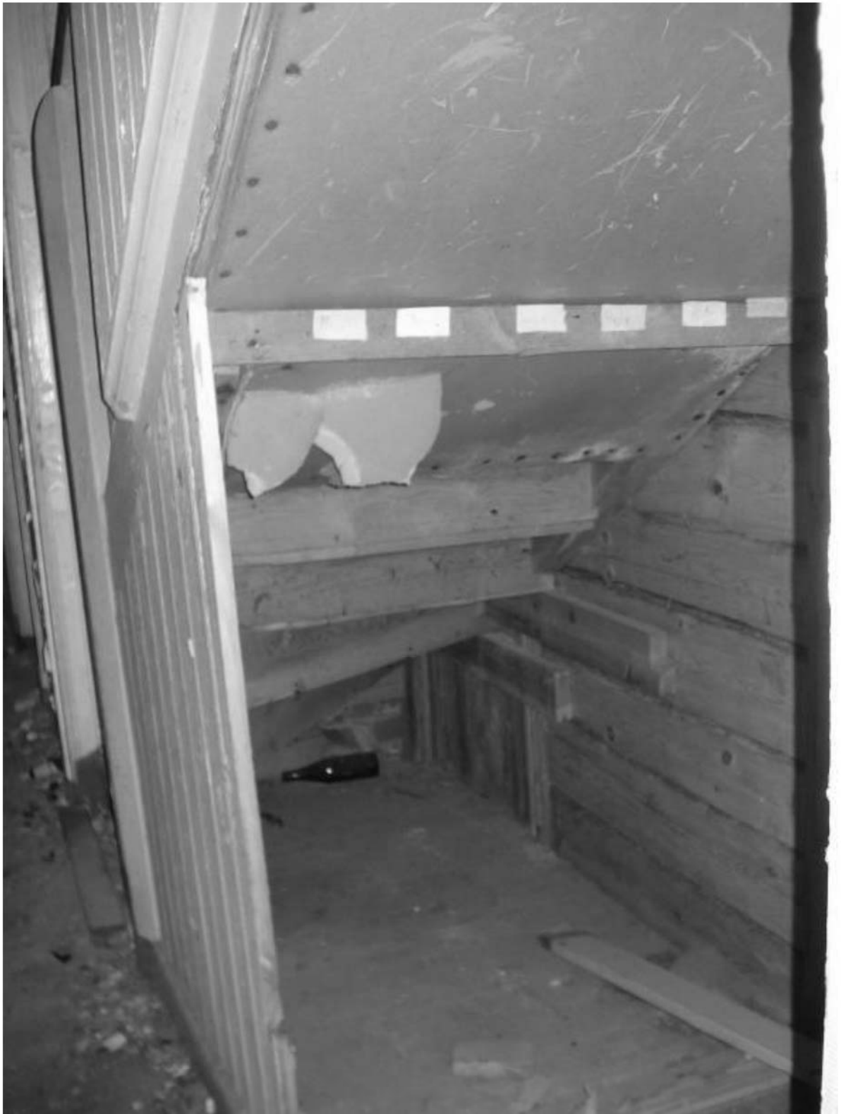
Рис. 89. Дача литера Б. Комната 9. Внутренняя лестница на 2-й этаж. Декабрь 2011 г.
