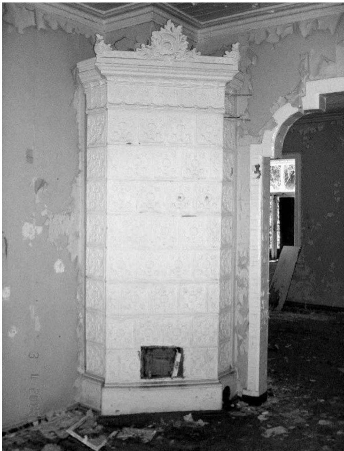
Рис. 47. Комарово. Морская ул. 8. Дача литера Б. Комната 2. Печь. 2005. Фото. Из материалов историко-культурной экспертизы ОКН «Дача», выполненной ООО «ДевРос» в 2012 г. Эксперты: Богданова Е.И., Полетайкин В.В., Иониди Э.Л.
