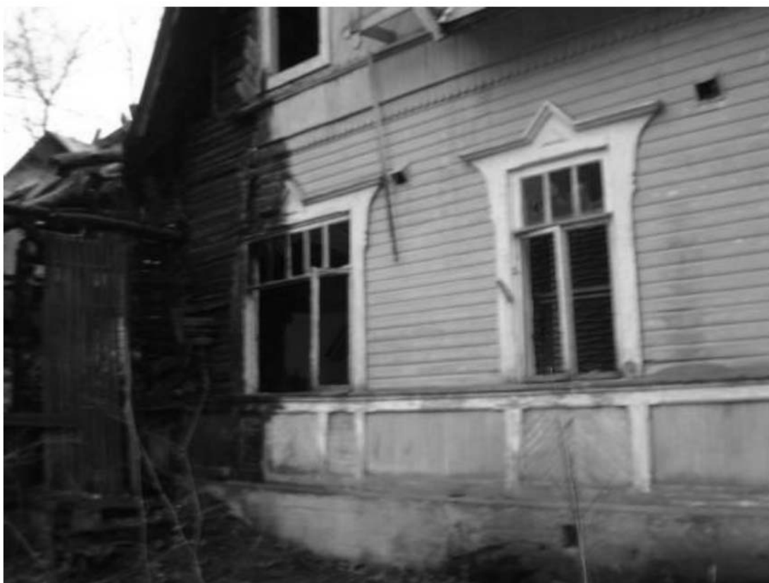
Рис. 58. Дача литера Б. Западный фасад. Декабрь 2011 г.
