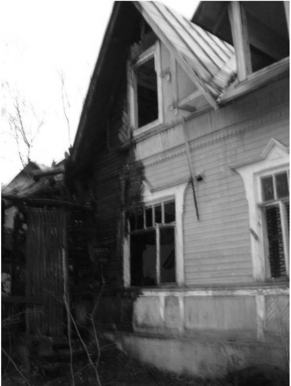
Рис. 57. Дача литера Б. Западный фасад. Декабрь 2011 г.
