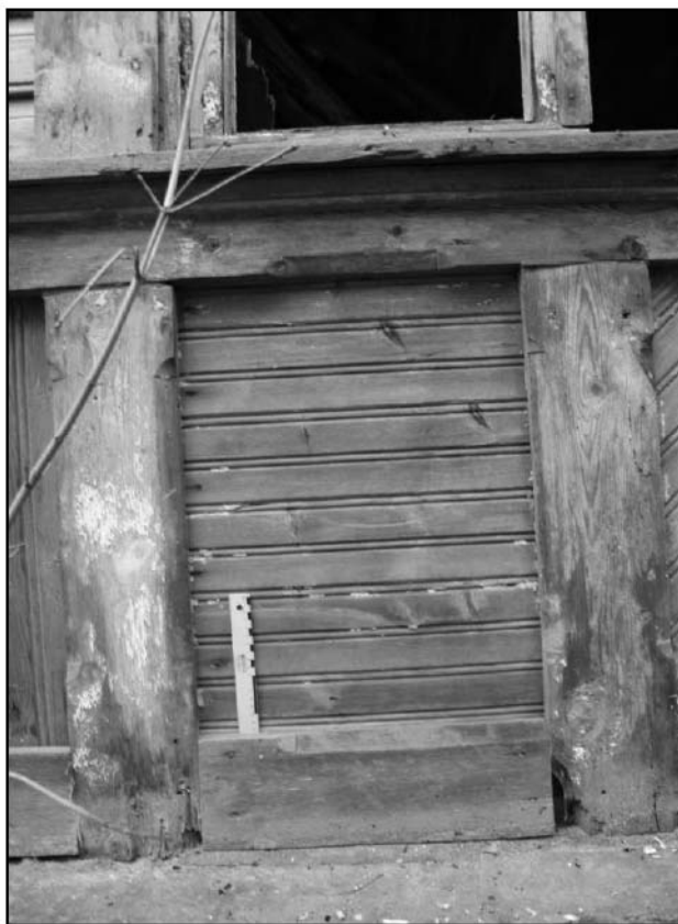
21. Объект культурного наследия «Дача» (пос. Комарово. Морская ул., 8). Фрагмент отделки стен под окнами восточного фасада.
