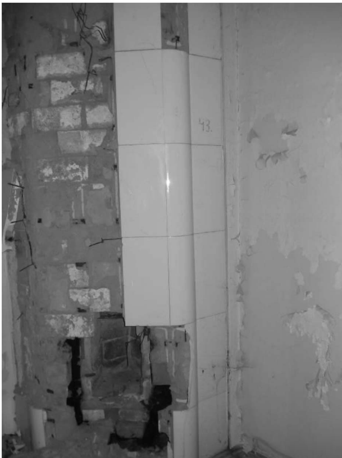
Рис. 81. Дача литера Б. Печь с частично утраченной облицовкой из белого кафеля.
