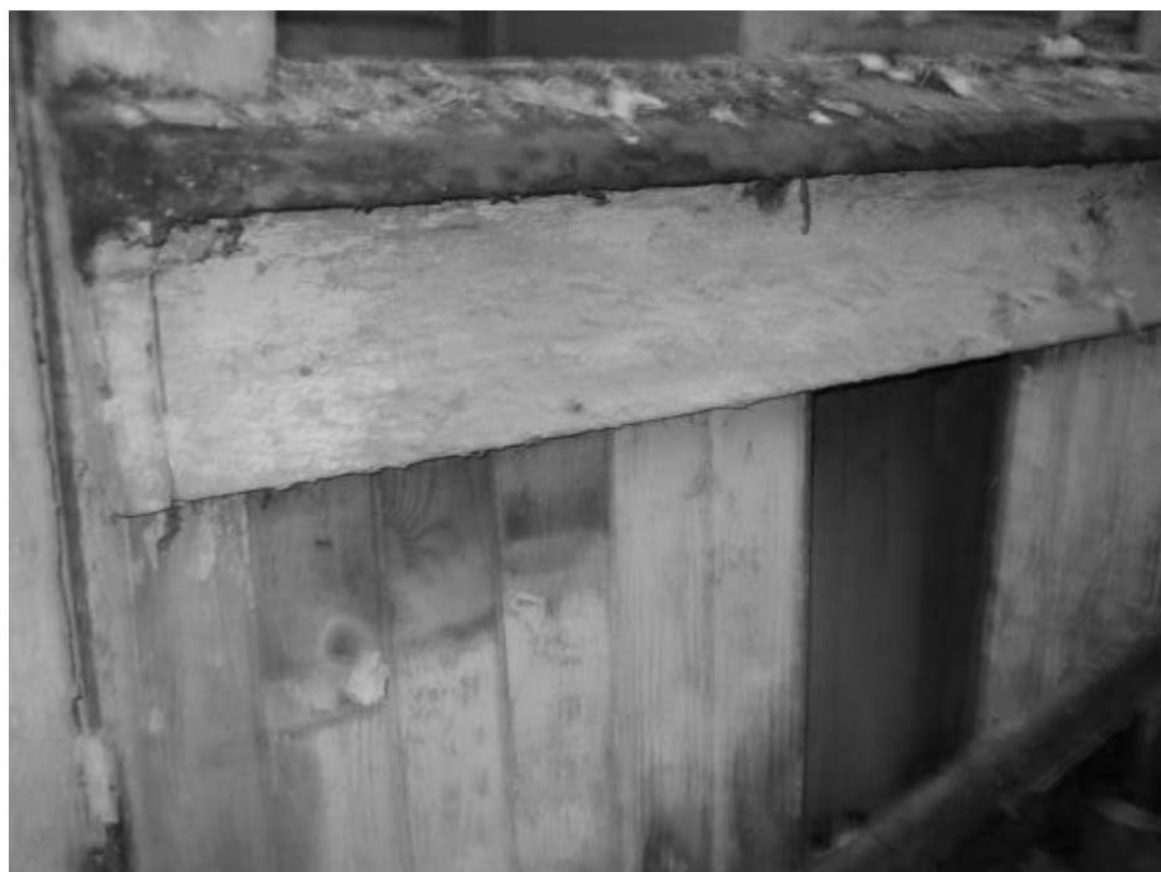
Рис. 94. Дача литера Б. Облицовки фасада. Декабрь 2011 г.
