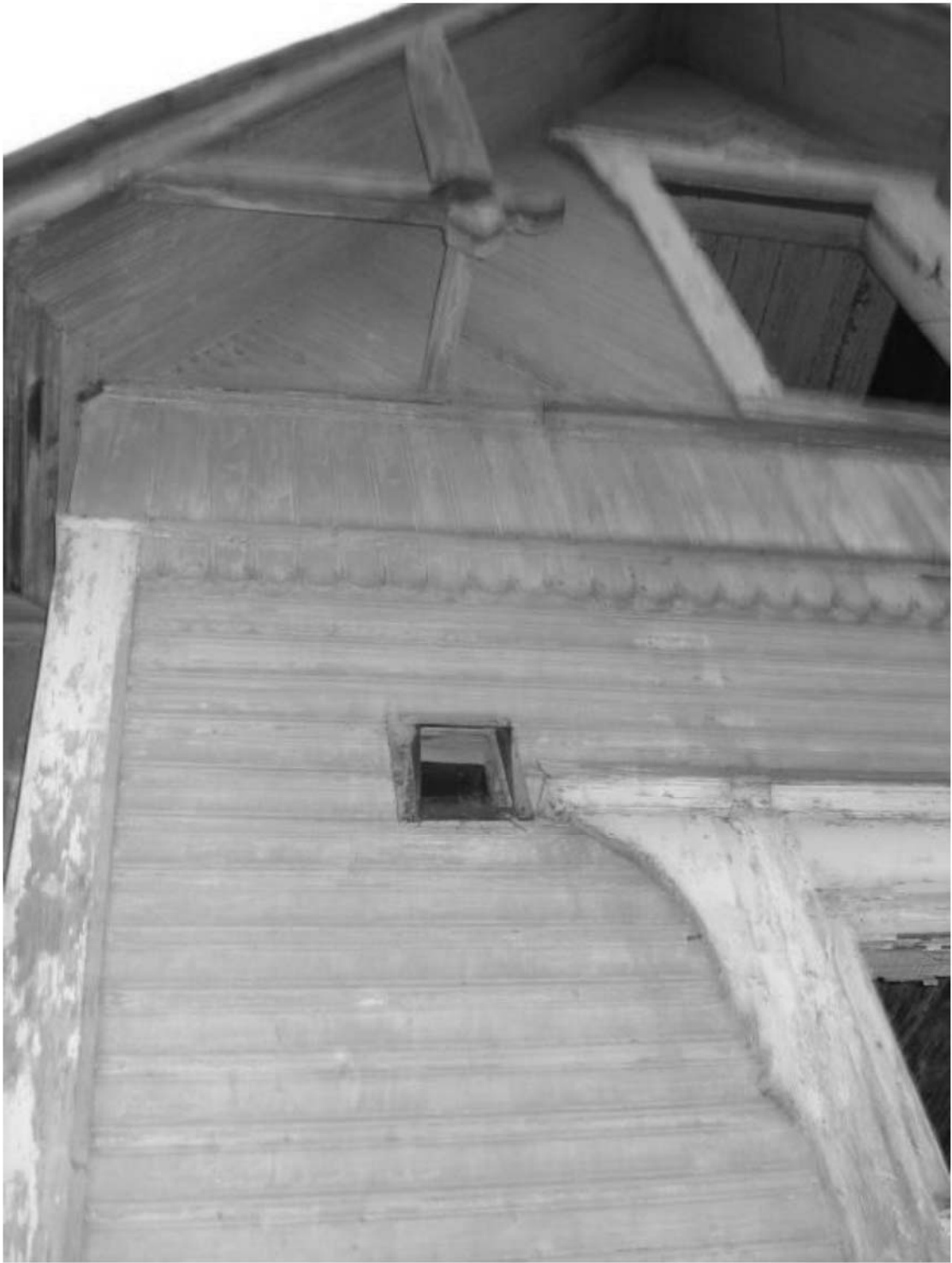
Рис. 92. Дача литера Б. Ризалит восточного фасада (фрагмент). Декабрь 2011 г.
