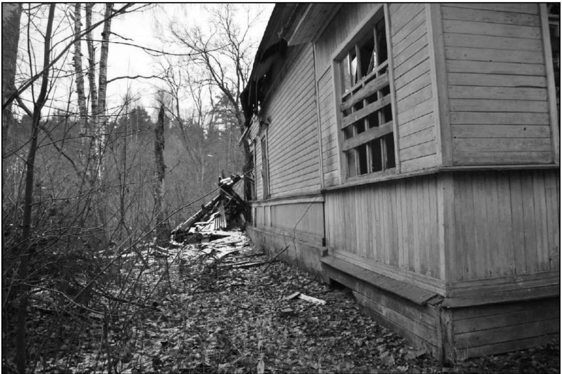
6. Объект культурного наследия «Дача» (пос. Комарово. Морская ул., 8). Западный фасад. Вид на север.
