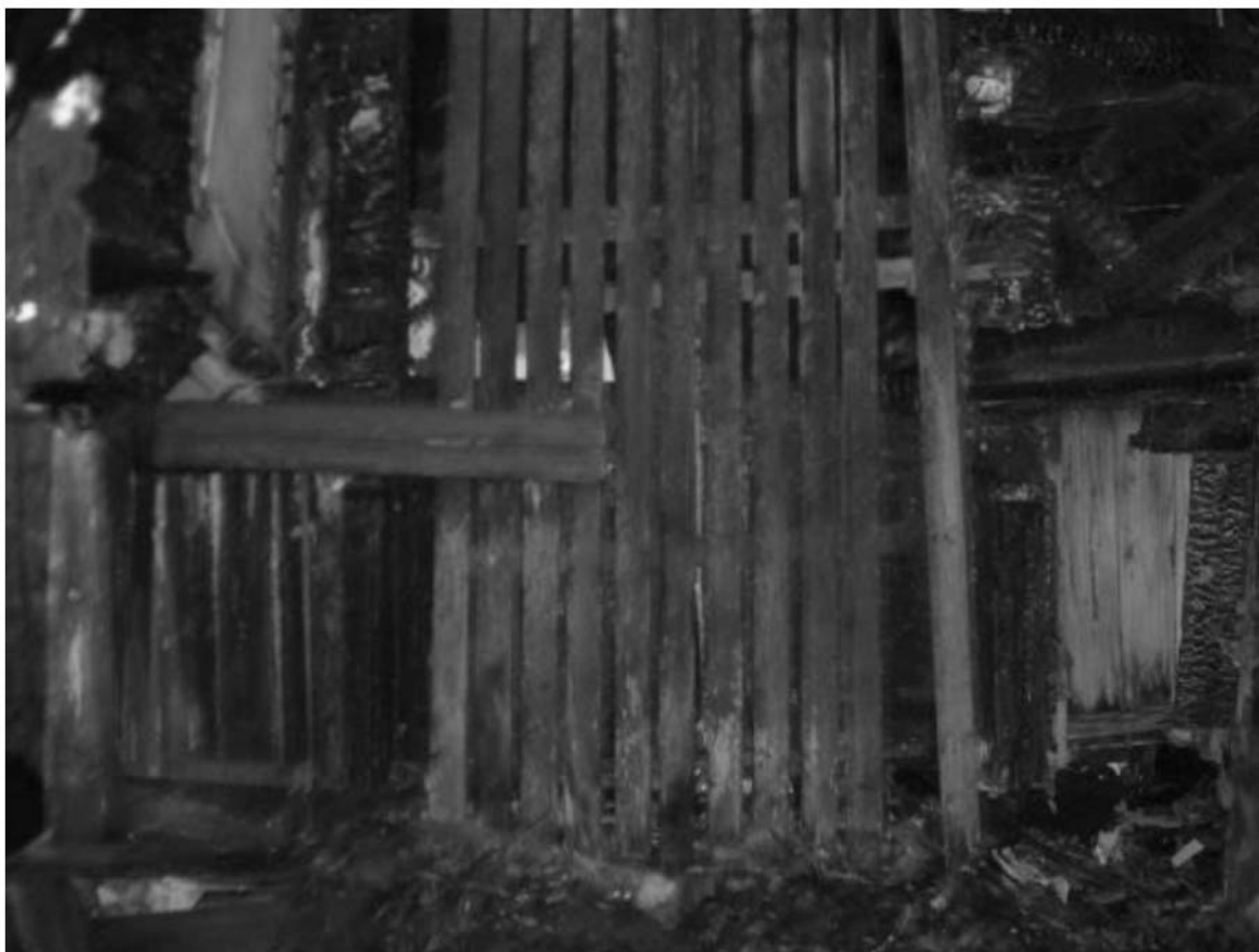
Рис. 61. Дача литеры Б. Западный фасад. Декабрь 2011 г.
