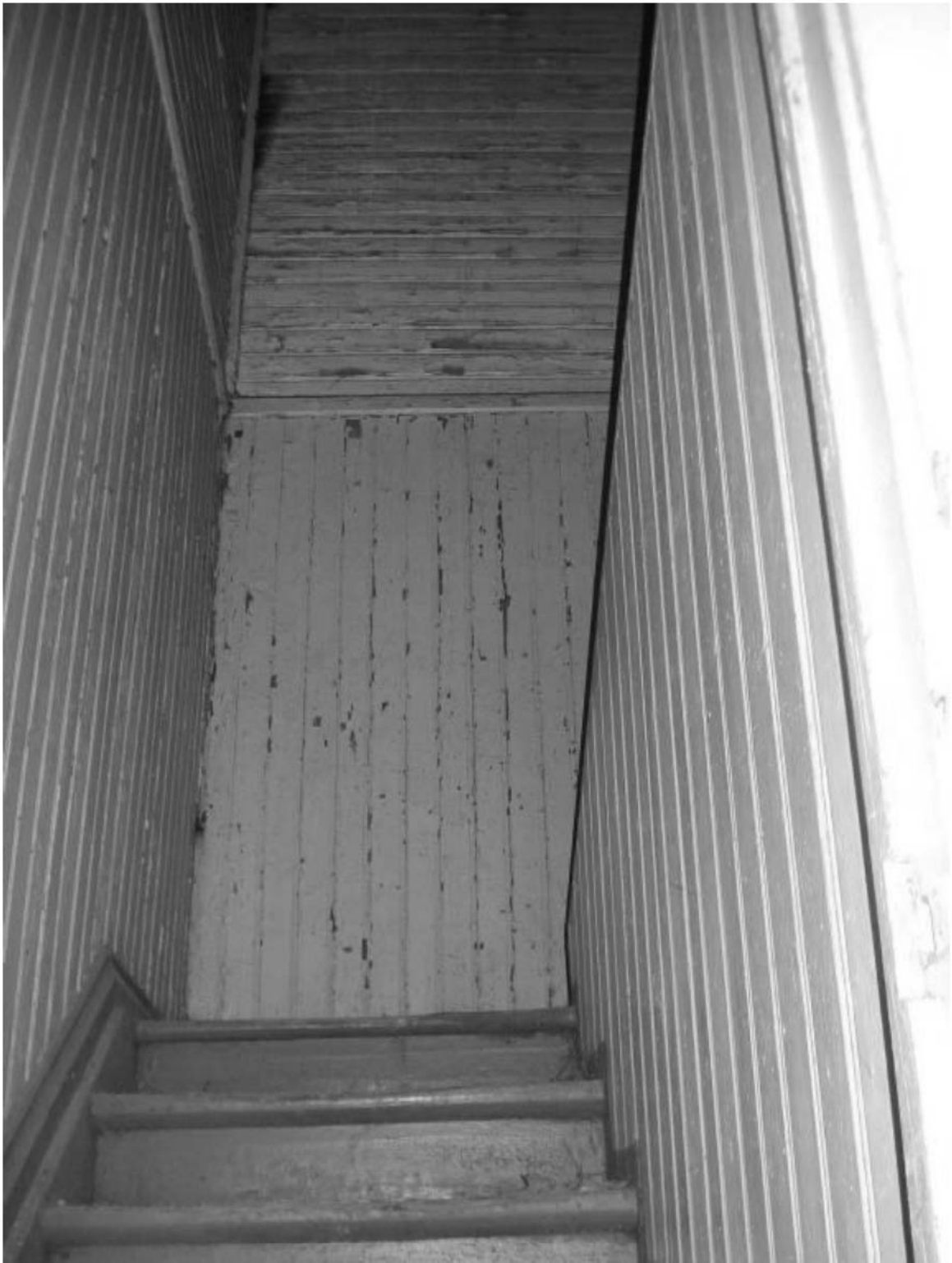
Рис. 87. Дача литера Б. Комната 9. Внутренняя лестница на 2-й этаж. Декабрь 2011 г.
