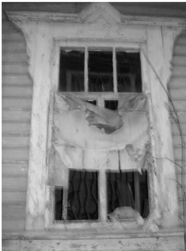
Рис. 90. Дача литера Б. Восточный фасад. Окно и наличник. Декабрь 2011 г.
