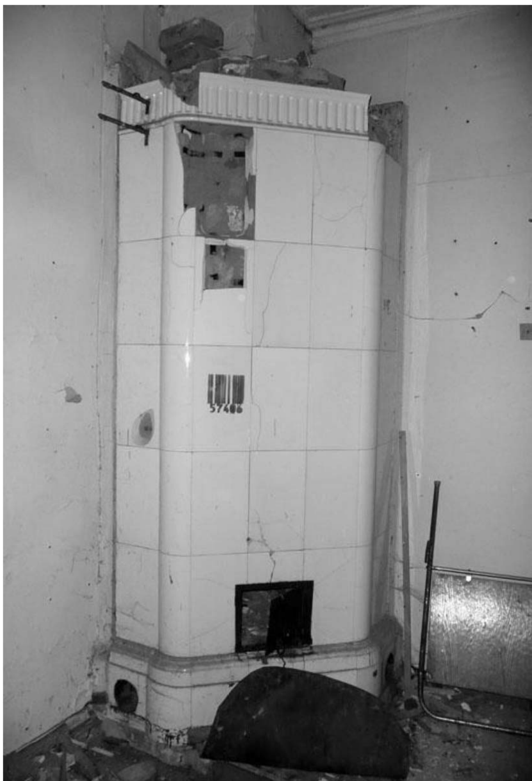
Рис. 45. Комарово. Морская ул. 8. Дача литера Б. Комната 4. Печь. 2008.Фото. Из материалов историко-культурной экспертизы ОКН «Дача», выполненной ООО «ДевРос» в 2012 г. Эксперты: Богданова Е.И., Полетайкин В.В., Иониди Э.Л.
