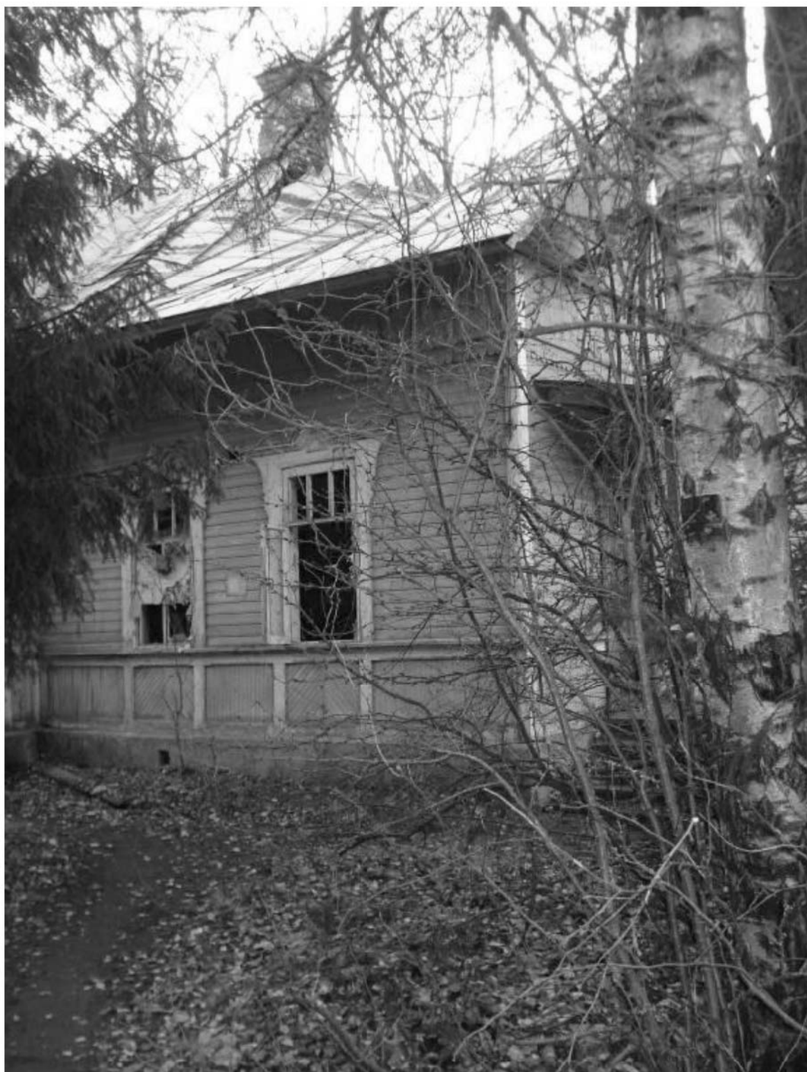
Рис. 65. Дача литера Б. Восточный фасад. Декабрь 2011 г.
