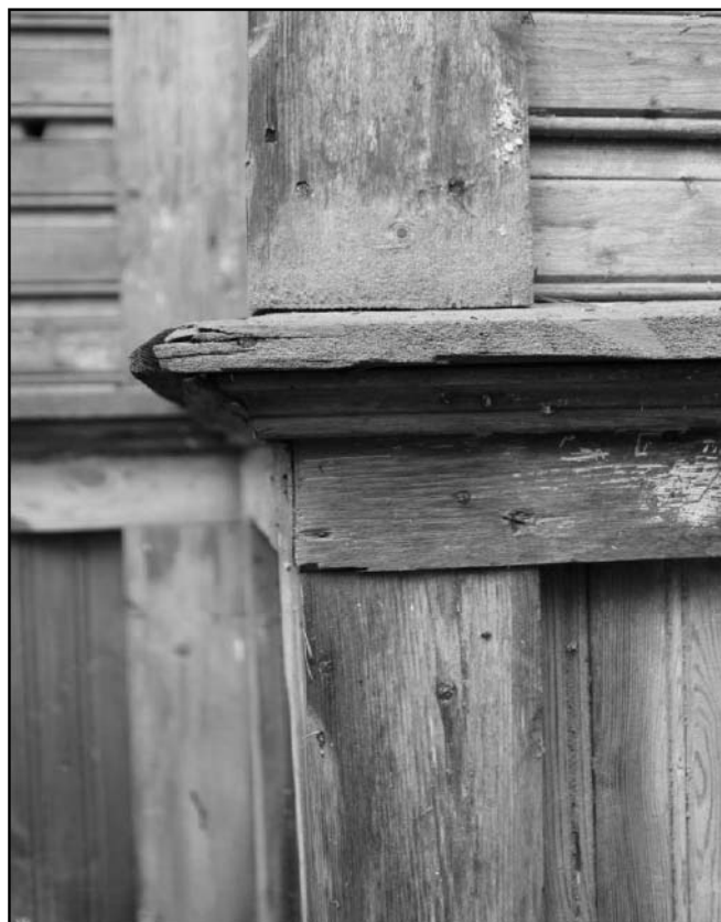
22. Объект культурного наследия «Дача» (пос. Комарово. Морская ул., 8). Угловой карниз Фрагмент отделки стен под окнами восточного фасада.
