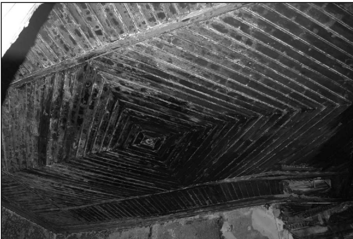
28. Объект культурного наследия «Дача» (пос. Комарово. Морская ул., 8). Помещение № 10. Потолок.
