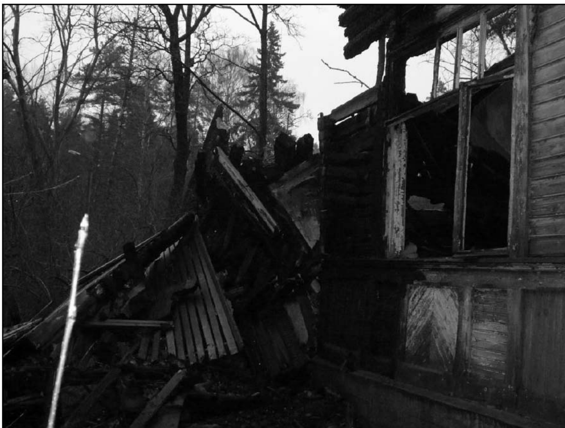
7. Объект культурного наследия «Дача» (пос. Комарово. Морская ул., 8). Сгоревшая северная часть дачи. Фрагмент западного фасада. Вид на северо-восток.
