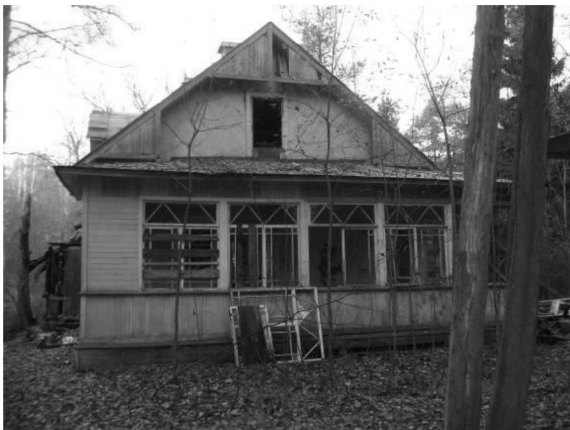
Рис. 59. Дача литера Б. Южный фасад. Декабрь 2011 г.
