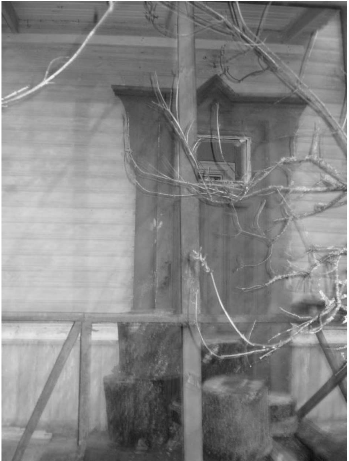
Рис. 66. Дача литеры Б. Северный фасад. Крыльцо, дверь. Декабрь 2011 г.
