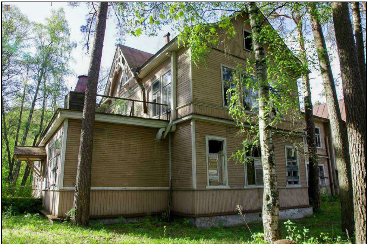
28. Дача Кирхнера. Вид с юго-восточной стороны. Веранда южного фасада расширена, южное крыло восточного фасада надстроено вторым этажом предположительно в середине XX в. Фото: Martti Rinta. Май 2015 г. Сайт terijoki.spb.ru .
