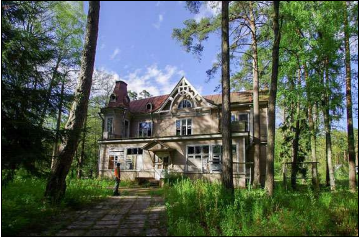
27. Дача Кирхнера. Южный фасад здания. Фото: Martti Rinta. Май 2015 г. Сайт terijoki.spb.ru .
